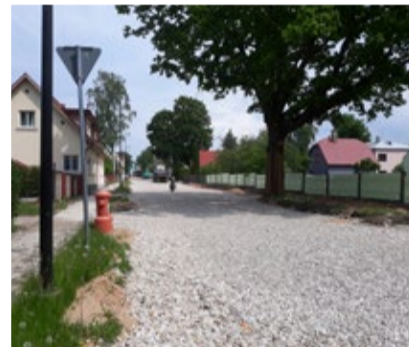
Ehitusjärgus Kalevipoja ja Koidula tänavad, kuhu paigaldatakse vanalinna miljõesse sobiv betoonkivikate.
