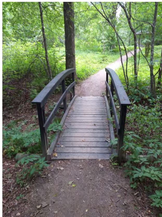
Kuva 22. Noron yli kulkevat puusillat ovat melko hyväkuntoisia.
